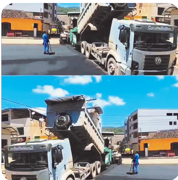
Ruas da sede de Ubaporanga recebem pavimentação asfáltica
