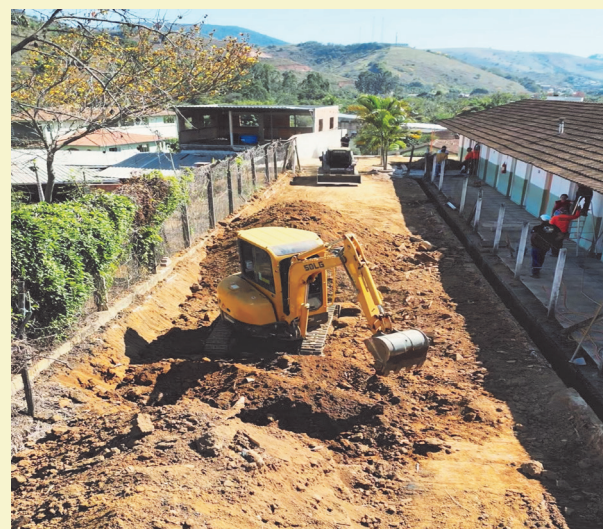
As obras da construção da nova creche seguem a todo vapor
