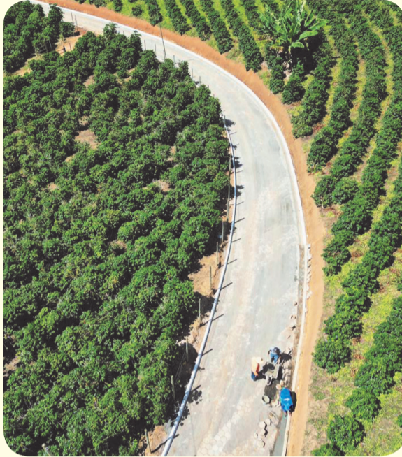
Prefeitura de Ubaporanga acelera o desenvolvimento e transforma a zona rural com obras de pavimentação
