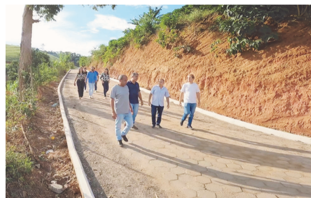
Zé Rufino e vereadores acompanharam a realização das obras no Córrego dos Valerianos
