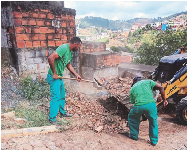
Funcionários da secretaria de Meio Ambiente trabalharam em várias frentes da limpeza e capina
