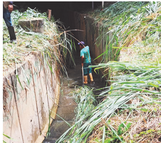
Limpeza dos rios e córregos também foram feitas por funcionários da prefeitura
